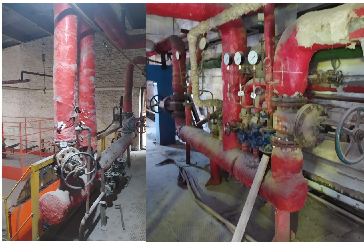
Рисунок 1.15 – Внешний вид паровых коллекторов котельной № 2 «КНИ»
