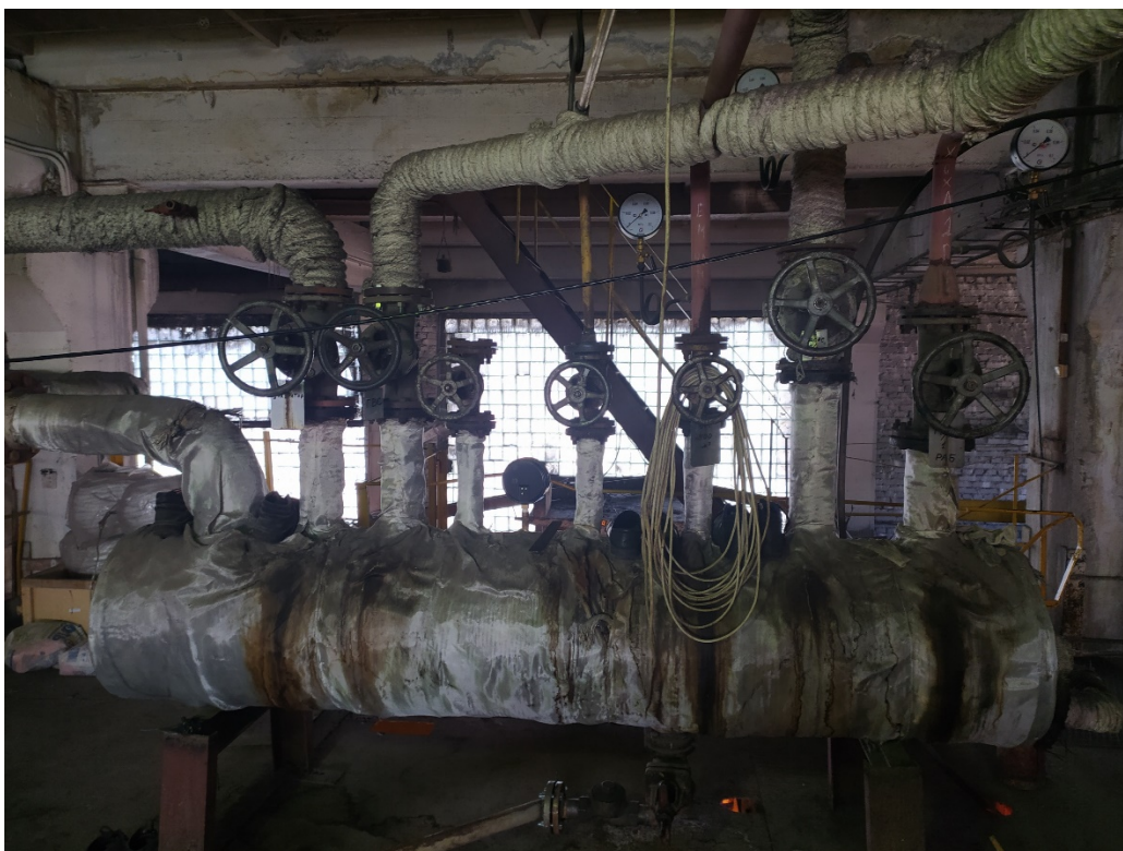
Рисунок 1.14 – Внешний вид парового коллектора котельной № 1 «Ровное»
